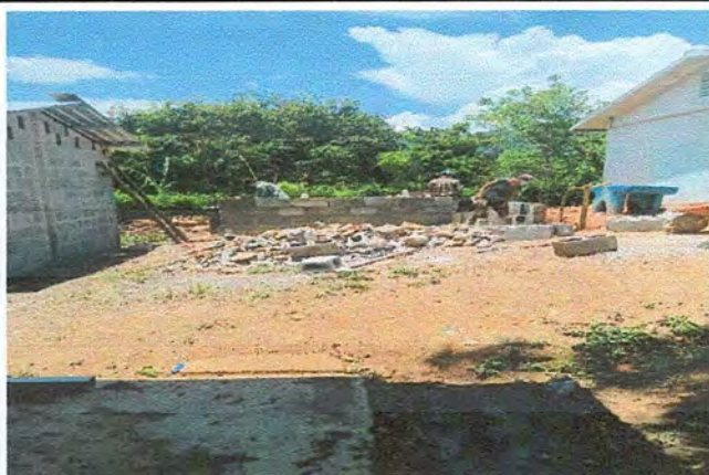
Foto 3: MEJORAMIENTO Y AMPLIACION DE ESTRUCTURA DE LAVAMANOS.
