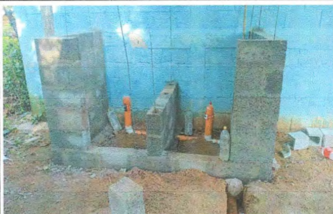
Foto 3: MEJORAMIENTO Y AMPLIACION DE SERVICIOS SANITARIOS
