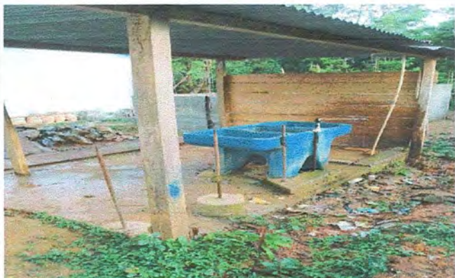
Foto 1: MEJORAMIENTO Y AMPLIACION DE ESTRUCTURA DE LAVAMANOS.
