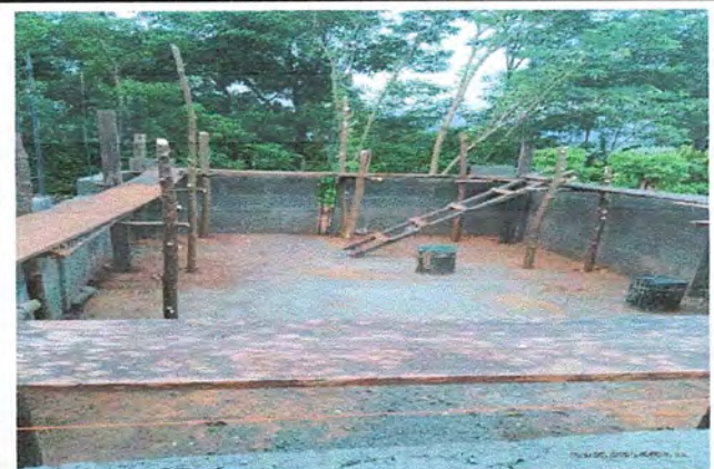
Foto 3: Reparación o sustitución de area de cocina.
