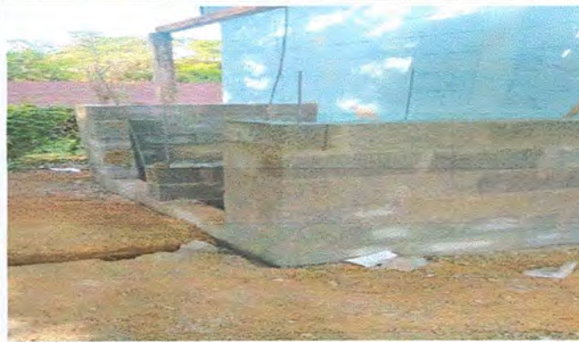
Foto 2: MEJORAMIENTO Y AMPLIACION DE SERVICIOS SANITARIOS
