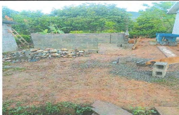
Foto 2: MEJORAMIENTO Y AMPLIACION DE ESTRUCTURA DE LAVAMANOS.
