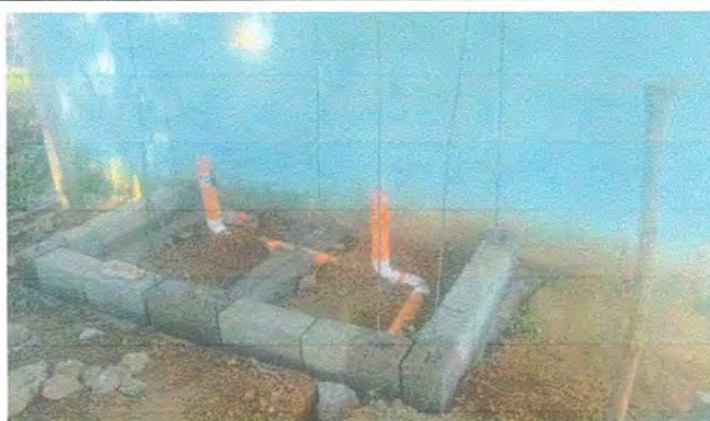
Foto 1: MEJORAMIENTO Y AMPLIACION DE SERVICIOS SANITARIOS
