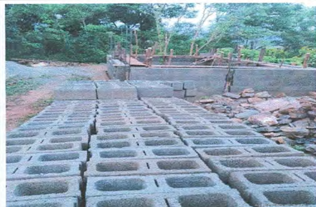
Foto 4: Reparación o sustitución de area de cocina.
