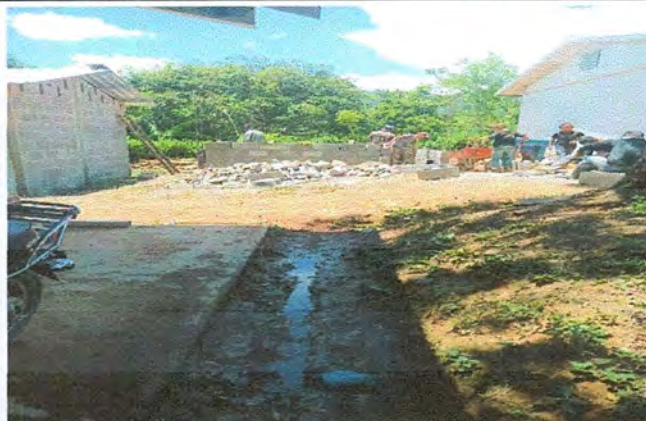
Foto 4: MEJORAMIENTO Y AMPLIACION DE ESTRUCTURA DE LAVAMANOS.
