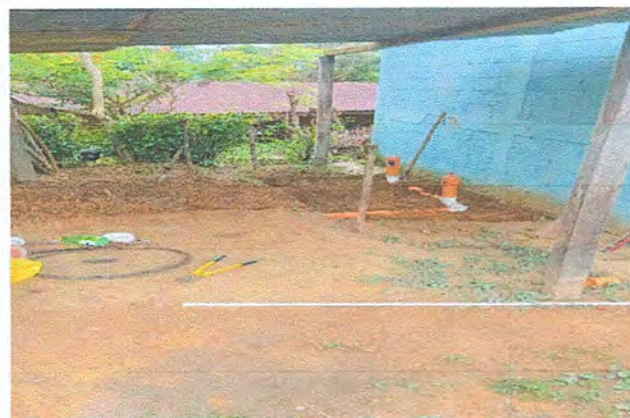
Foto 4: MEJORAMIENTO Y AMPLIACION DE SERVICIOS SANITARIOS
