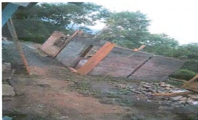
Foto 1: Reparación o sustitución de area de cocina.
