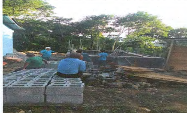
Foto 2: Reparación o sustitución de area de cocina.
